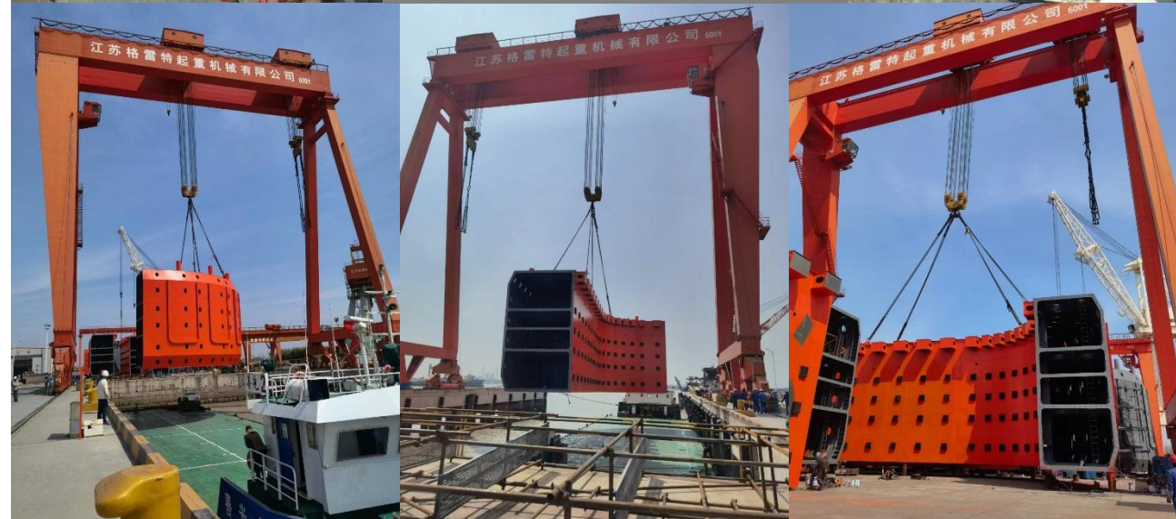
防撞箱在公司码头拼装、装船照片
